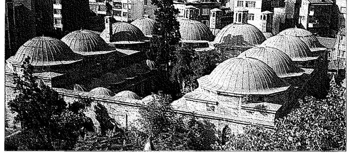
Amcazâde Hüseyin Paşa Külliyesi'nin medrese bölümünün üstten görünüşü - Fatih / İstanbul
